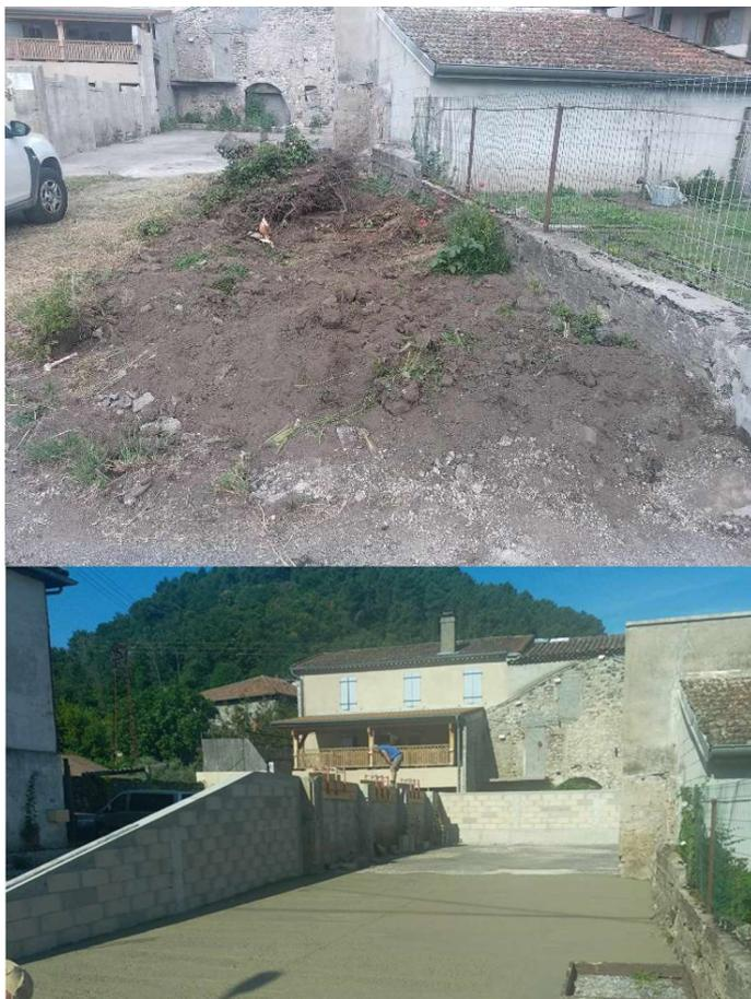
Les travaux ont consisté en la réfection du sol et en la construction d'un mur séparant les deux propriétés.
